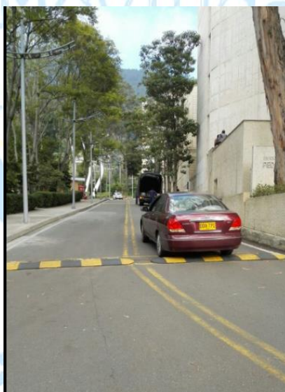
Figura 30. Reductores de velocidad en vías internas.
